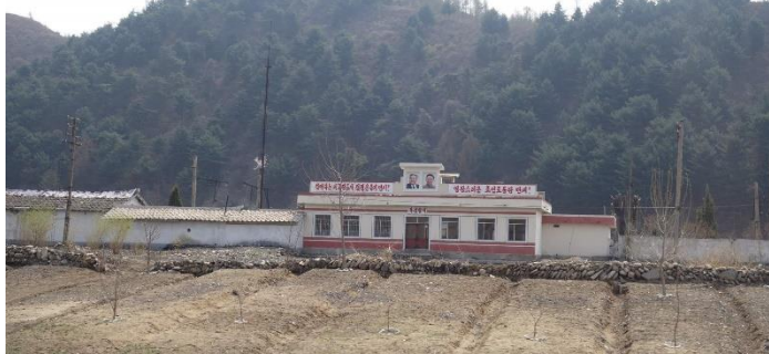
Železniční zastávka Puksinhjon
