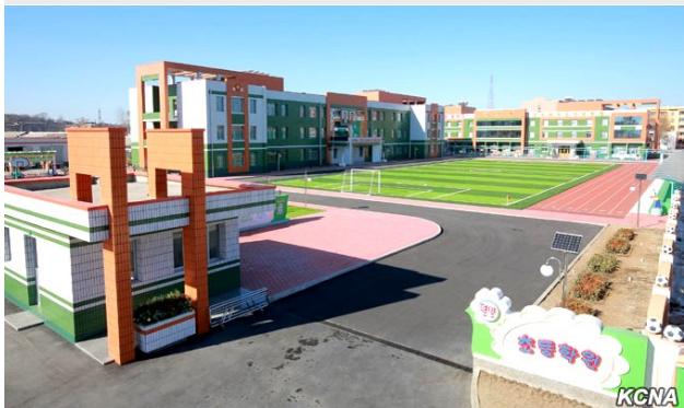
Nově postavená Pchjongjangská základní škola pro sirotky (únor 2017)
