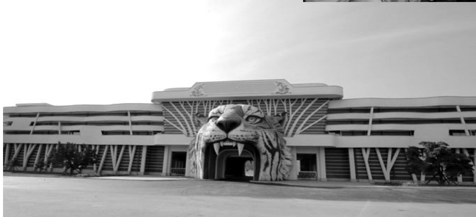
Rekonstruovaná Ústřední zoologická zahrada (květen 2016)
